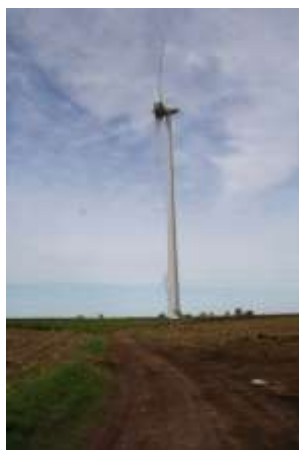
Visite d'une éolienne ENERCON
